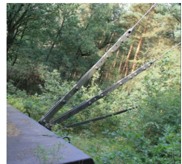
Befestigung der Spannseile beim Sendemast in Kirchlinteln
