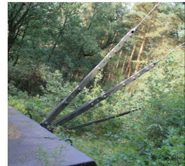
Befestigung der Spannseile beim Sendemast in Kirchlinteln
